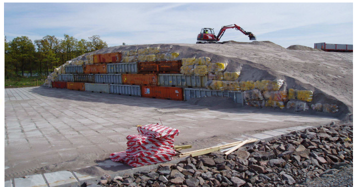
1.6-6 pav. Atliekų krovimo suprojektuotame LMAA atliekyne konceptualioji schema ir veikiančio Švedijos Oskarshamn AE atliekyno nuotrauka
