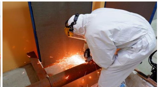
5.10.2-2 pav. Avarijos 2-ajame energijos bloke likvidavimo darbai (kairėje – avarijų šalinimo komandos personalo instruktavimas, dešinėje – trūkusio vamzdžio remontas)
