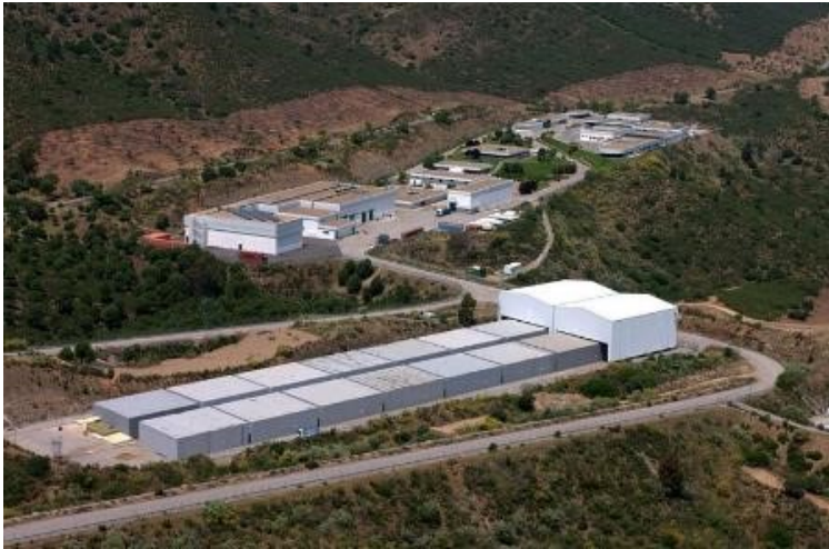
El Cabril repository in Spain
