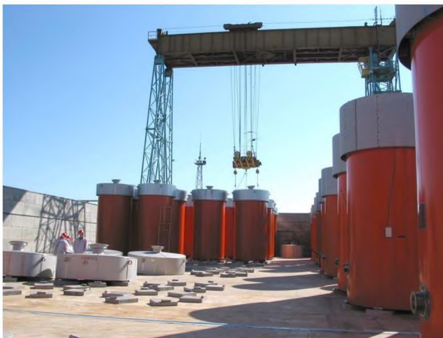
Pav. 1.7-1 Sausojo tipo tarpinė panaudoto branduolinio kuro saugykla
