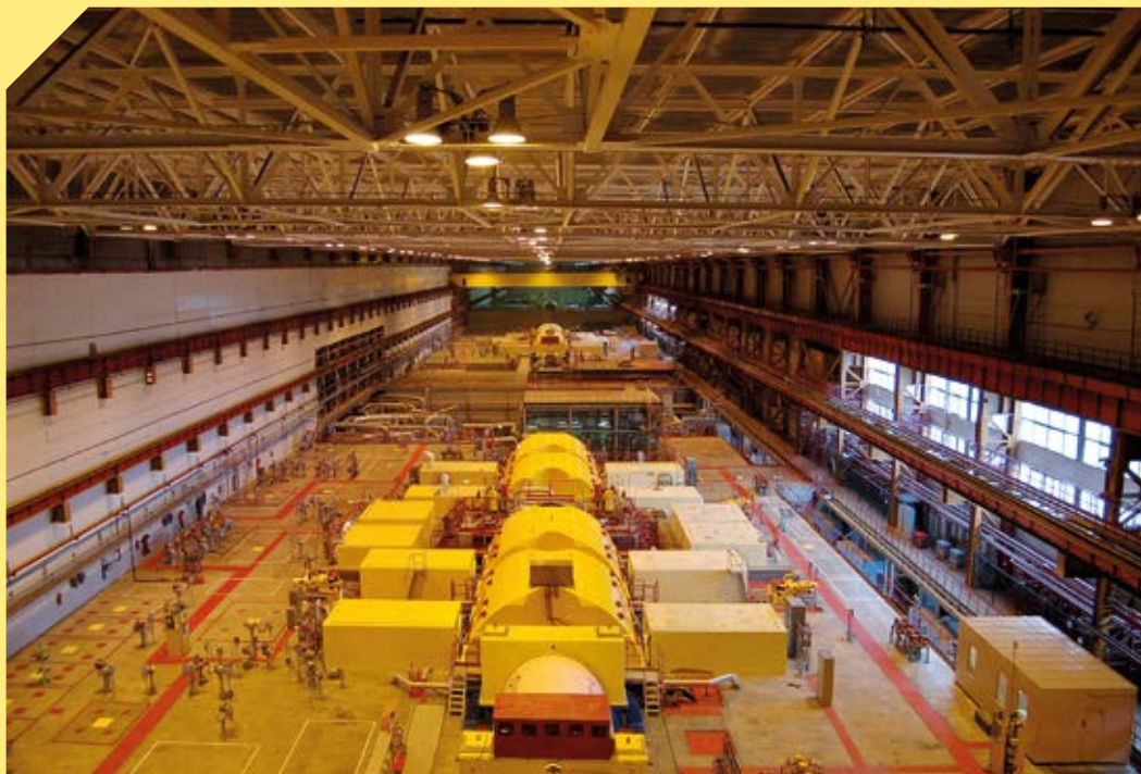
Turbinų salė iki išmontavimo ↗
