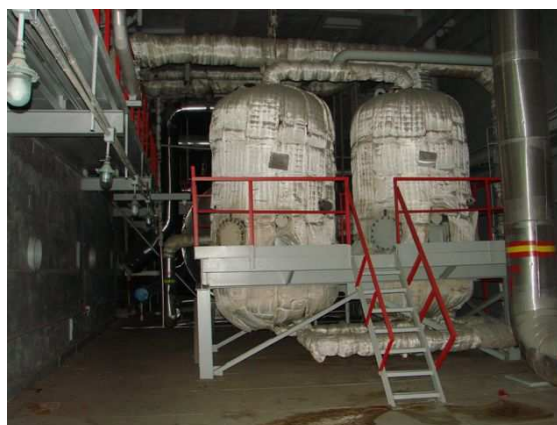
2.1.-5. pav. Deaatoriaus bako ir deaeratorių perpilimo plėstuvų +27.60 atž. nuotrauka
