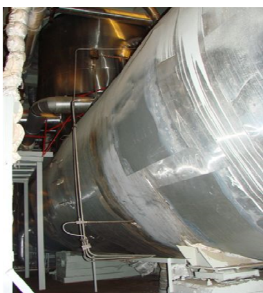
2.1.-5. pav. Deaatoriaus bako ir deaeratorių perpilimo plėstuvų +27.60 atž. nuotrauka
