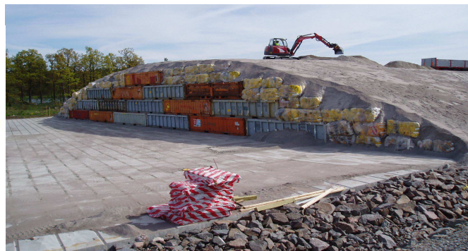
1.3.-7 pav. Konceptualioji atliekų krovimo suprojektuotame labai mažo aktyvumo atliekyno schema ir veikiančio Švedijos AE Oskarshamn atliekyno nuotrauka
