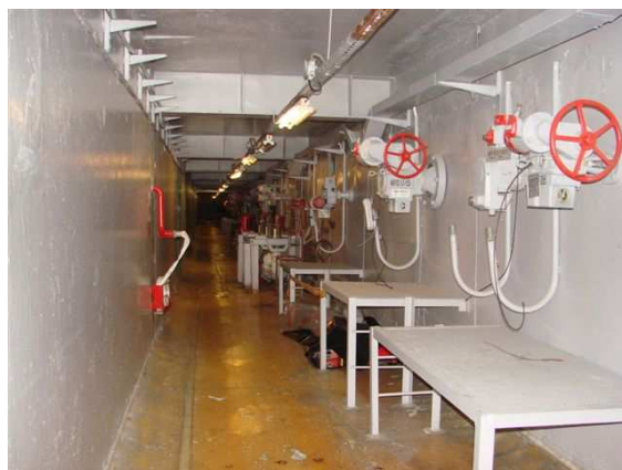
2.1.-4. pav. Armatūros pavarų koridoriaus +32.40 atž. nuotrauka
