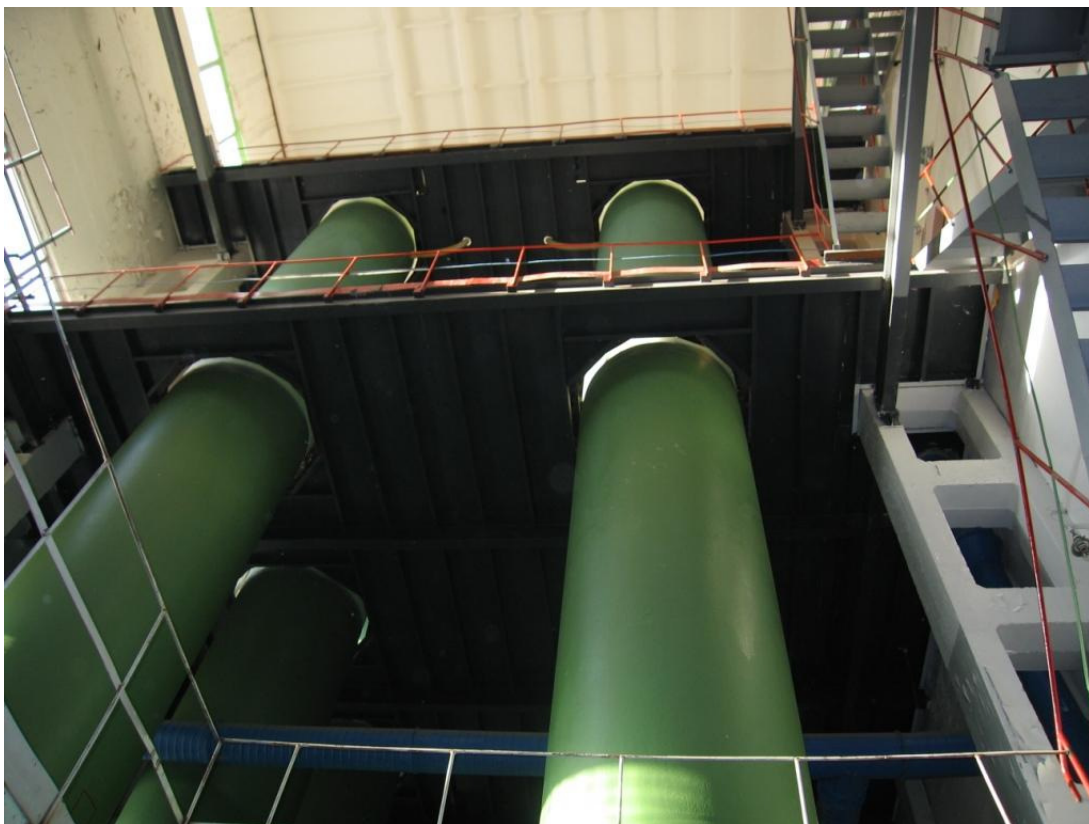
2.1.2-6 pav. Viršutinio aukšto bendrieji vaizdai: (a) pagrindinė salė, 401 patalpa. Viršutinės RAAS hidrobaliūnų dalys; (b) pagrindinė salė, vaizdas iš rūšio aukšto į viršų. RAAS hidrobaliūnai ir plieninės grindys +7,20 ir +13,20 m lygiuose
