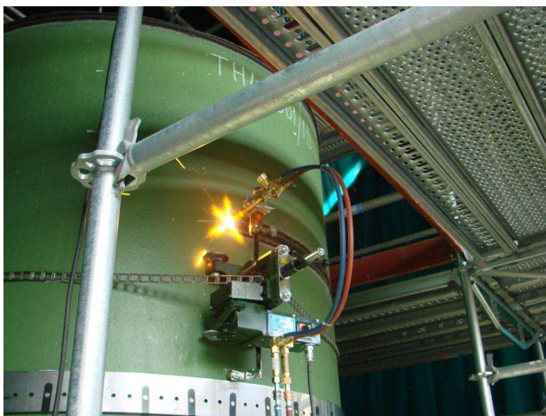
2.1-4.pav. Automatizuotas plazminio pjaustymo įrenginys (pirmojo energijos bloko RAAS HB išmontavimas)
