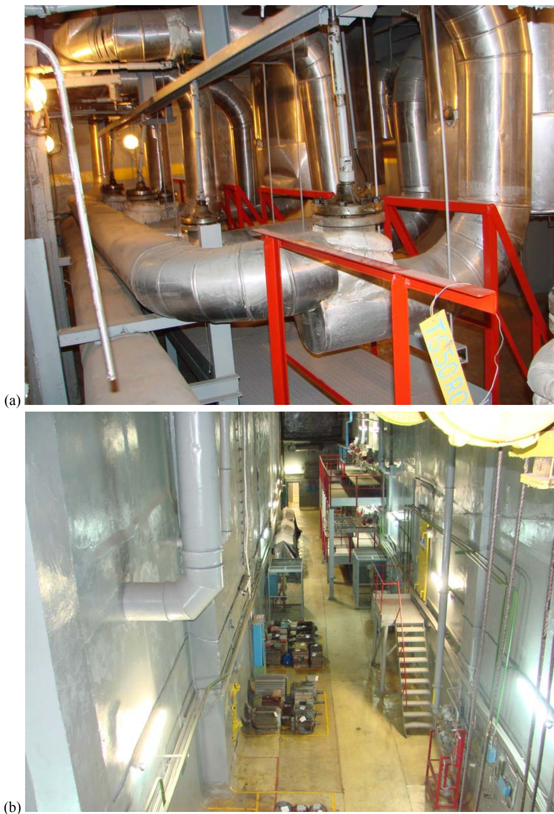
2.1.2-5 pav. V1 blokas +10,8 m lygyje: (a) zeolito filtrai ir vamzdynas 307 patalpoje; (b) aptarnavimo koridorius 319
