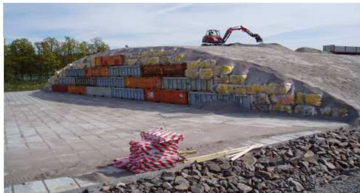
1.3-7 pav. Atliekų krovimo suprojektuotame LMAA atliekyne konceptualioji schema ir veikiančio Švedijos Oskarshamn AE atliekyno nuotrauka
