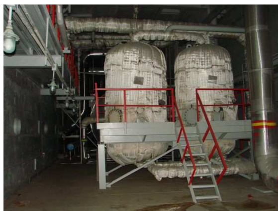
2.1.-5. pav. Deaeratoriaus bako ir deaeratorių perpylimo plėstuvų +27.60 atž. nuotrauka
