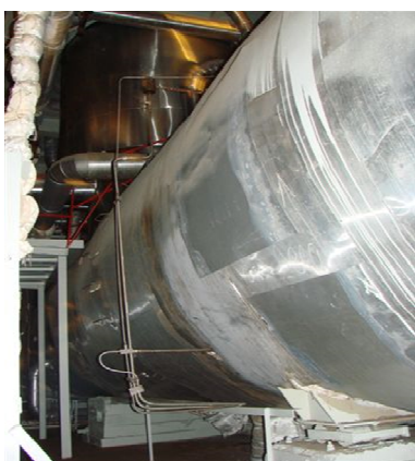
2.1.-5. pav. Deaeratoriaus bako ir deaeratorių perpylimo plėstuvų +27.60 atž. nuotrauka
