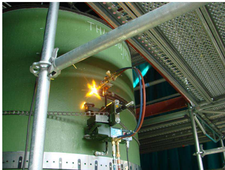
2.1-4.pav. Automatizuotas plazminio pjaušymo įrenginys (pirmojo energijos bloko RAAS HB išmontavimas)
