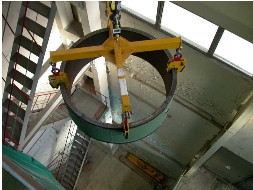
2.1-5 pav. RAAS HB nupjauto segmento perkėlimas (pirmojo energijos bloko RAAS HB išmontavimas)
