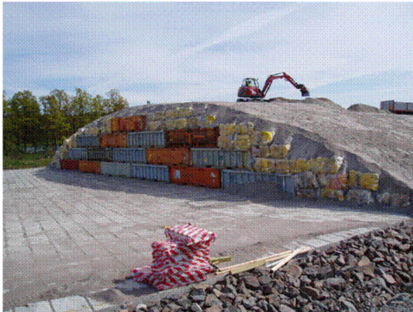
Рис. 3.13. Формирование выравнивающего слоя
