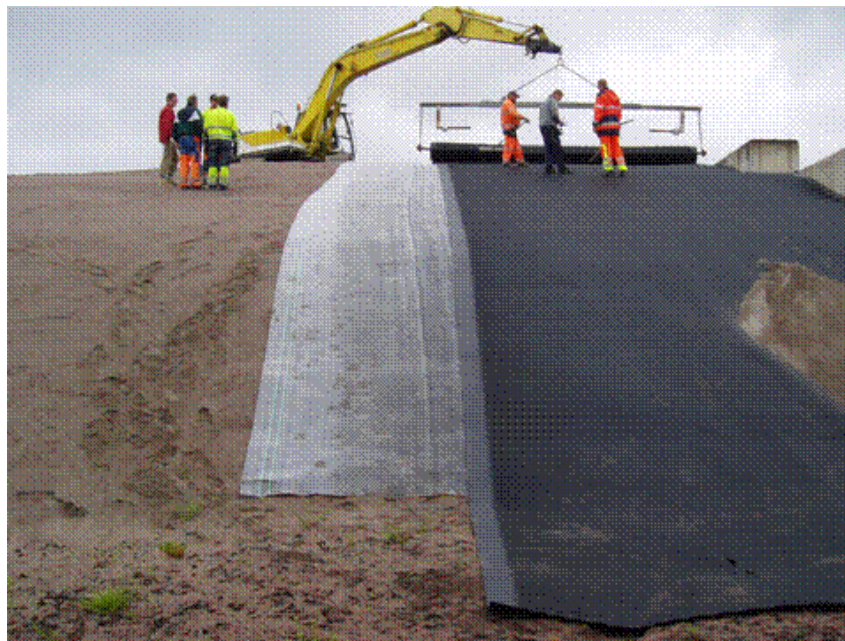
Рис. 3.14. Укладка бентонитного ковра и слоя из HDPE
