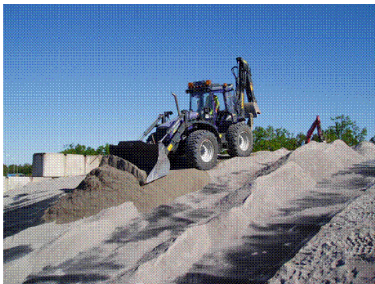
Рис. 3.16. Формирование дренажного слоя гравия, укладка геотекстильного материала, формирование слоя природного материала
