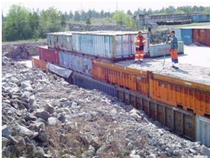
Рис. 3.12. Заполнение пустого пространства между контейнерами
