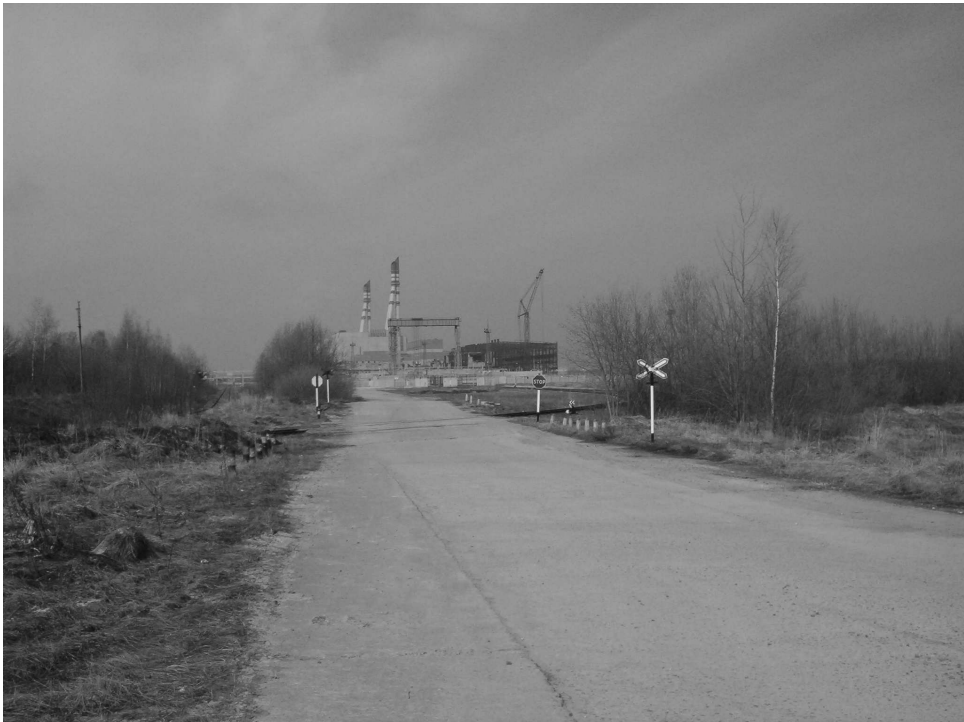
Рисунок 1. Вид с востока на 1-ый и 2-ой блоки ИАЭС и недостроенный (заброшенный) 3-ий блок
