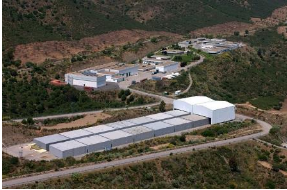
El Cabril repository in Spain
