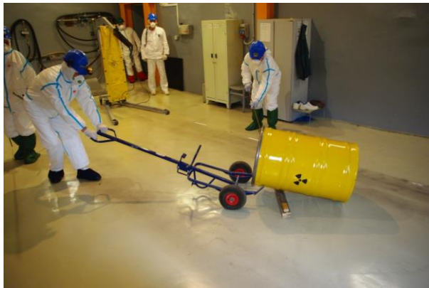
5.10.2-2 pav. Ruošiama įranga statinės pakėlimui į vertikalią padėtį.
