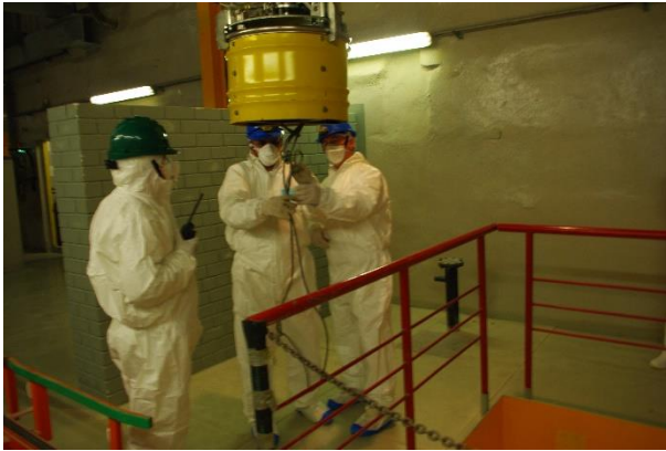
5.10.2-7 pav. Ruošiama įranga statinės pakėlimui į vertikalų padėtį
