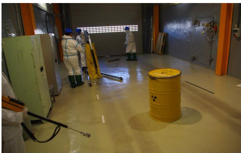
5.10.2-4 pav. Statinės transportavimas į pakuočių su grafitu kaupimo punktą.
