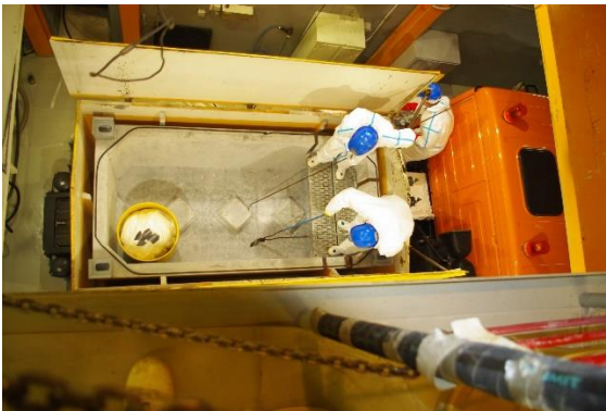
5.10.2-8 pav. Statinės pakėlimas į vertikalų padėtį, grafito surinkimas
